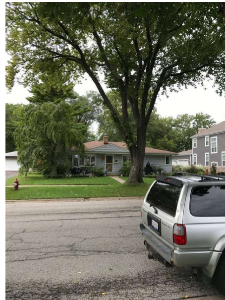
822 N. DRYDEN AVE. EXISTING
