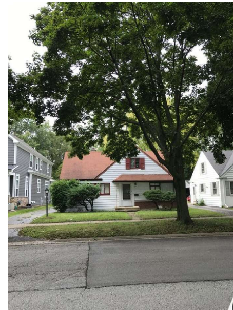
830 N. DRYDEN AVE. EXISTING
