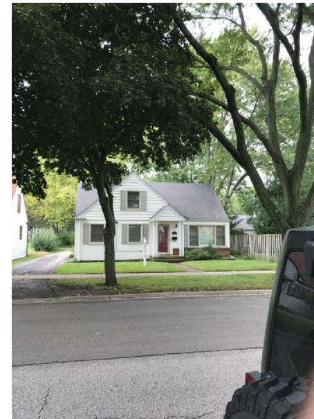
834 N. DRYDEN AVE. EXISTING
