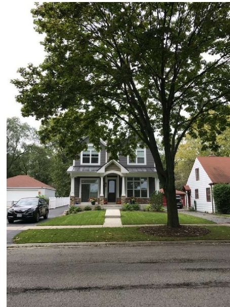
826 N. DRYDEN AVE. EXISTING
