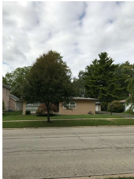
818 N. DRYDEN AVE. EXISTING
