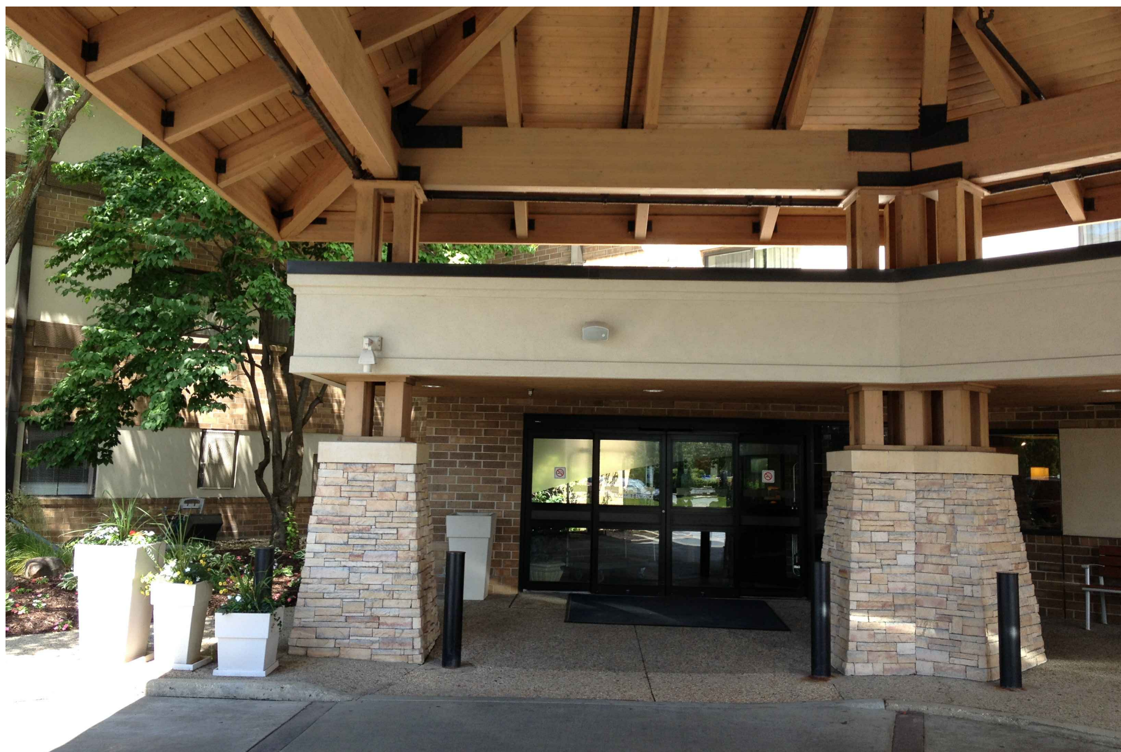
6 EXISTING ENTRY CARPORT SCALE: N.T.S.
