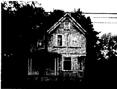
638 N. Highland Ave
