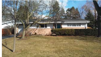
Subject Property 915 S. Dunton Ave.
