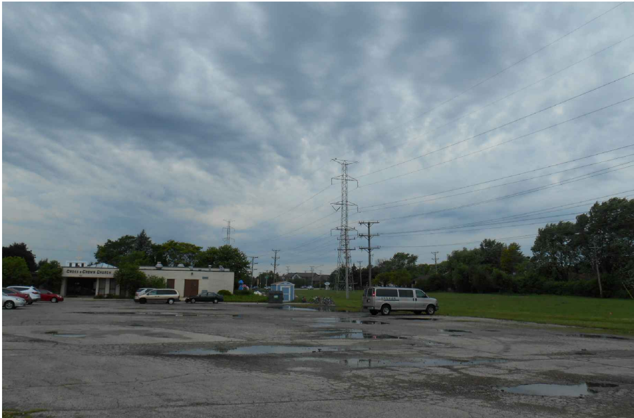
1 EXISTING ACCESS DRIVE SCALE: N.T.S.
