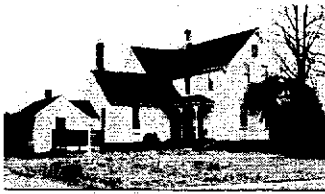
112 S. Rammer Ave. DEMOLISHED
